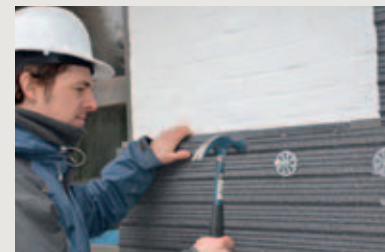
3 slagpluggen inkloppen Enfoncer les chevilles à frapper
