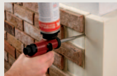
4 Afdichting Injecter la mousse
