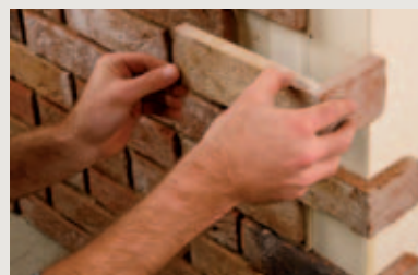
5 Aanbrengen verbindingsstrips Placer les plaquettes de raccord
