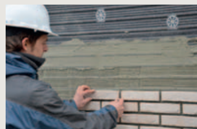
5 Steenstrips plaatsen Placer les plaquettes de briques
