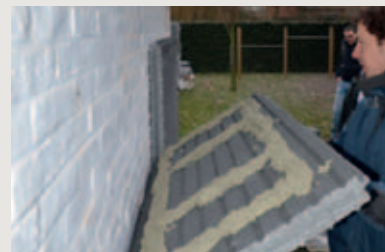
1 Aanbrengen lijm op isolatiepaneel Appliquer la colle sur le panneau d'isolation
