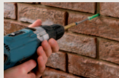
3 Bevestiging paneel Fixer les panneaux
