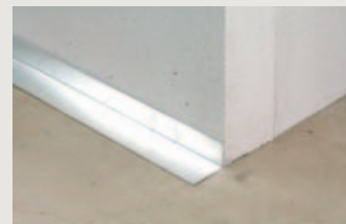
1 Plaatsing startprofiel Placer le profilé de départ
