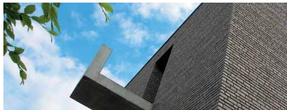
peut être gênante, même si le mortier est peu visible lorsque la maçonnerie Zero® a été correctement exécutée. Afin d'obtenir un effet uniforme, un mortier coloré ton sur ton est indiqué (par exemple un mortier rouge pour une brique rouge). Mais vous pouvez également opter pour un mortier plus foncé qui fait mieux ressortir l'effet ombré des joints.
